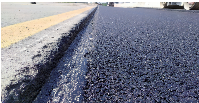
2. Esempio di stesa di conglomerato bituminoso per la realizzazione di una pavimentazione stradale, tema di cui si è trattato nei webinar di Febbraio 2024
