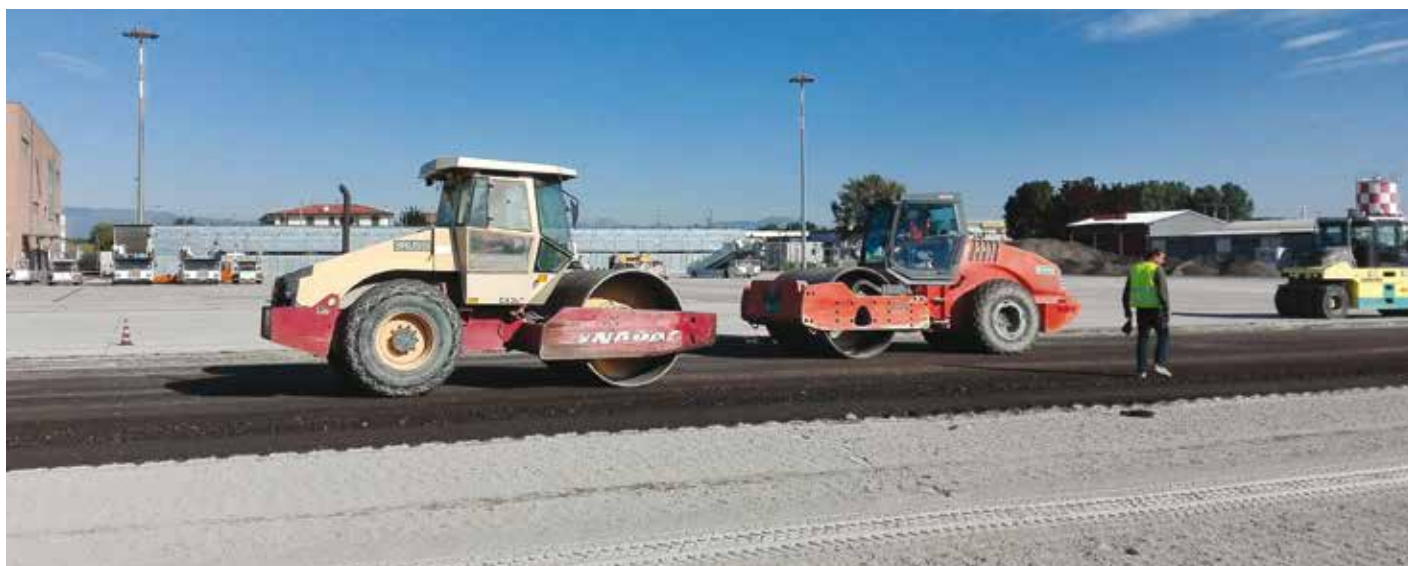
2. Gli investimenti pubblici nelle infrastrutture viarie hanno subito una forte ripresa nello scorso quinquennio
