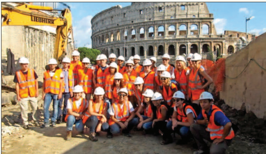
5. Visita al cantiere Metro C di Roma-Fori Imperiali
