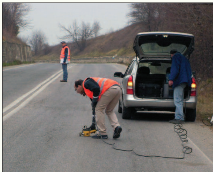
2. Il rilievo eseguito con il georadar
