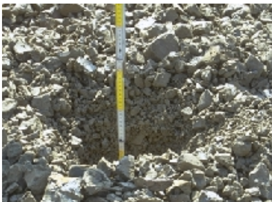
Figura 1 – Aspetto del terreno con calce dopo pochi passaggi della fresa
