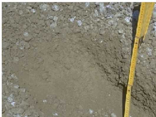
Figura 2 – Aspetto del terreno con calce dopo molti passaggi della fresa
