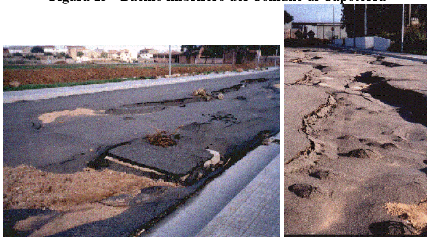
Figura 16 - Strada comunale che conduce al cimitero di Capoterra.
