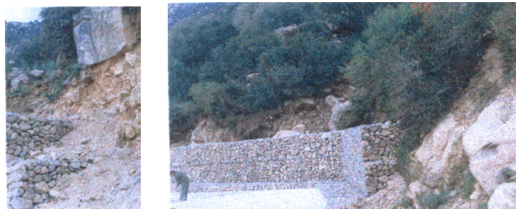
Figura 14 - S.S. n°387: frana lungo la scarpata di monte e intervento con gabbionate.
