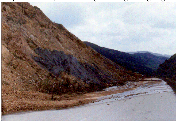
Figura 8 - Frana lungo la scarpata di trincea della S.P.n°22
