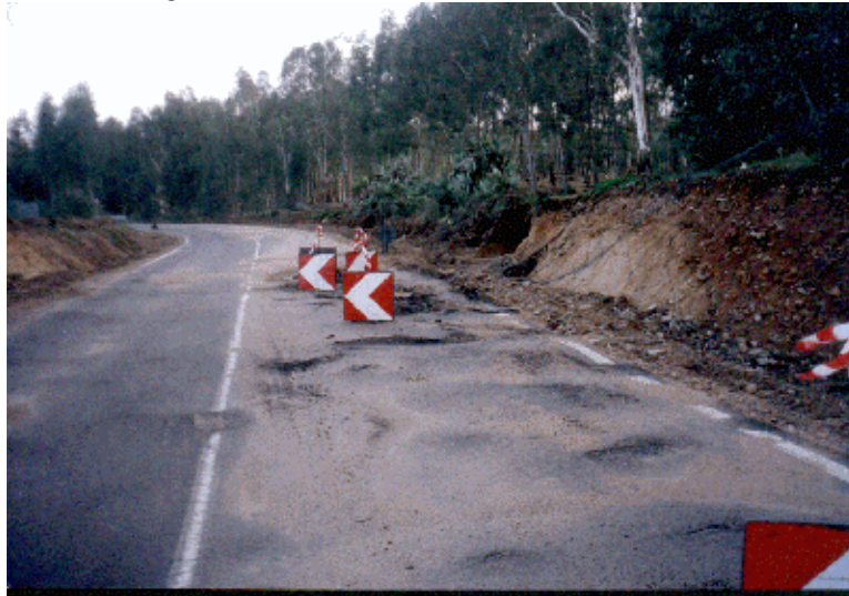
Figura 17 - Strada comunale tra Capoterra e Santa Lucia
