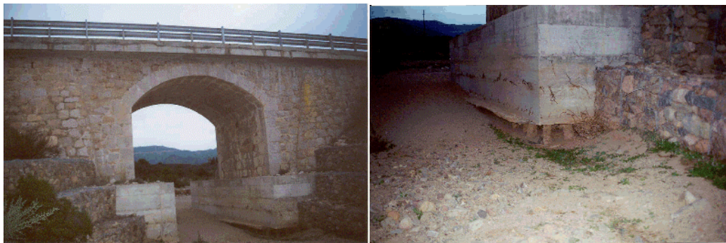
Figura 13-S.S. n°125: problemi di scalzamento dovuti alla riduzione della sezione idraulica
