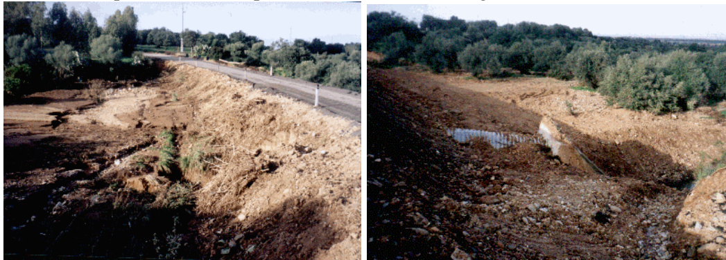
Figura 18 - Rilevato ricostruito sulla strada Capoterra-Santa Lucia
