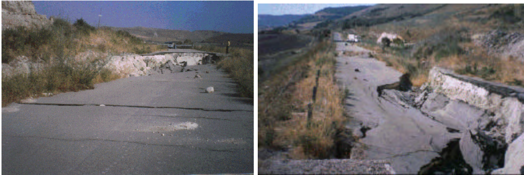
Figura 4 - Ittiri: Collasso della strada provinciale Ittiri-Florinas.
