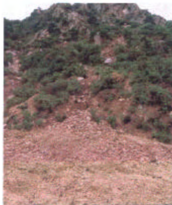
Figura 9 - Frana lungo la scarpata della S.S.n°125
