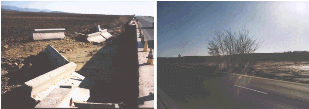
Figura 19 - S.S.n°128 cedimento della banchina in prossimità di Barrali.
