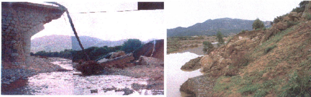
Figura 11 - S.S. n°125 crollo della spalla laterale del ponte e gabbionate danneggiate dalla frana
