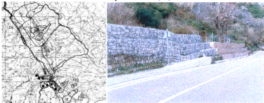
Figura 7 - Osini: Fronte di frana e gabbionate sulla S.P. n°11
