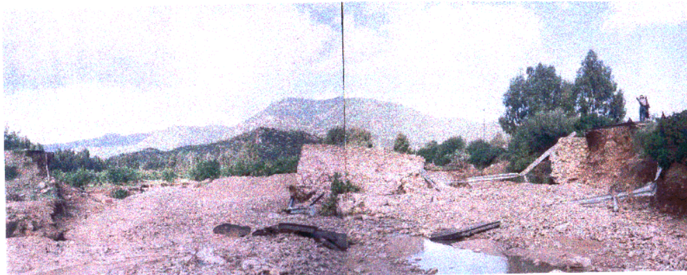
Figura 10 - S.S. n°125, Ponte crollato in seguito all'azione dirompente dell'acqua
