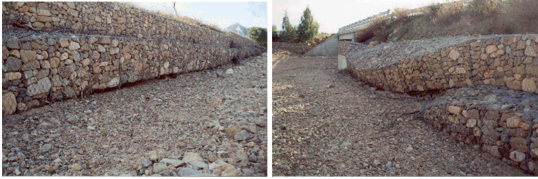
Figura 12 - S.S. n°125: ribaltamento ed errata realizzazione delle gabbionate
