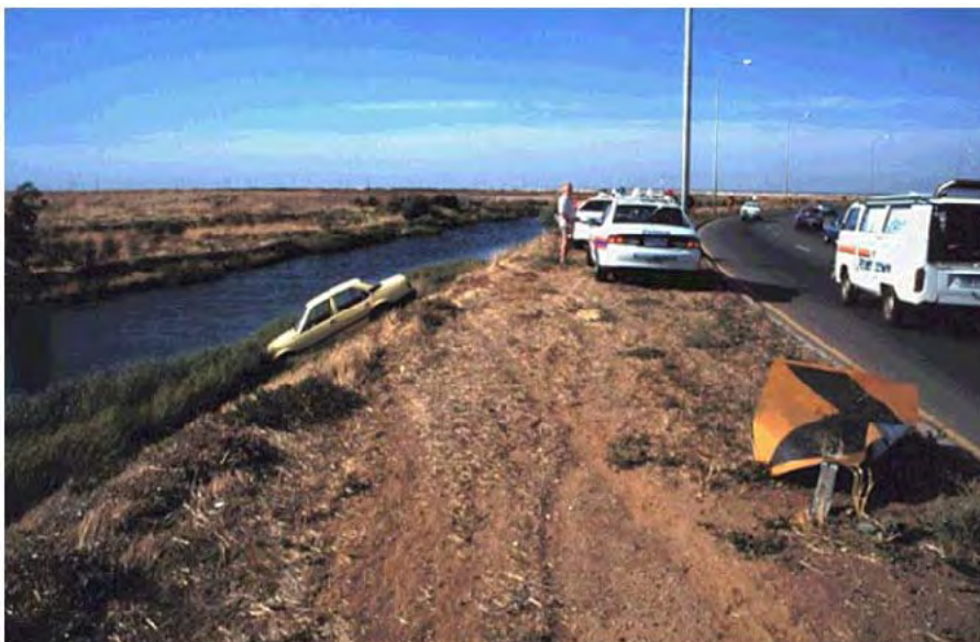
Figura 2 – Incidente per fuoriuscita dalla sede stradale e caduta dal rilevato.
