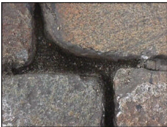
Figura 16 – Giunto ripulito dalla sigillatura bituminosa
