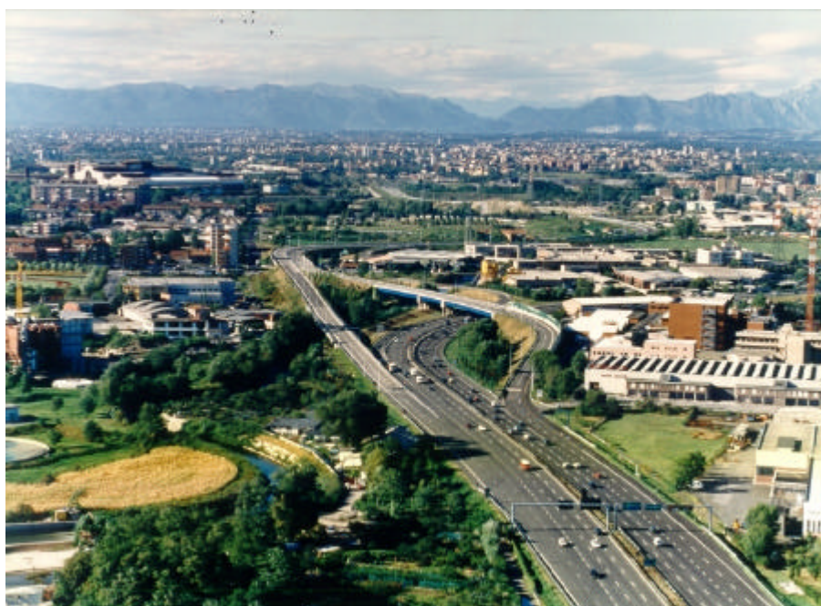
Figura 2 – Panoramica della zona attraversata dal Peduncolo, dallo svincolo di C.na Gobba sulla Tangenziale Est verso nord
