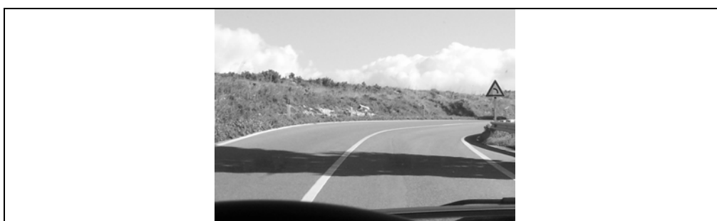
Figure 6 Site n. 1 (S.S. n. 547)
