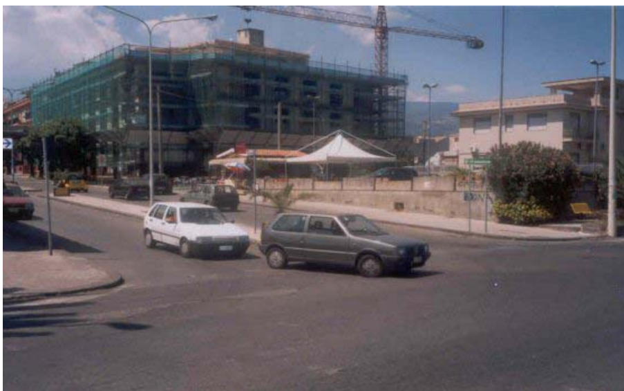
Figure 3: Intersection n° 1. Viale Amendola - Lungomare Pantano (Riposto)
