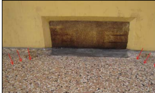
Figura 10: Lesioni presenti in prossimità delle bocche di lupo
