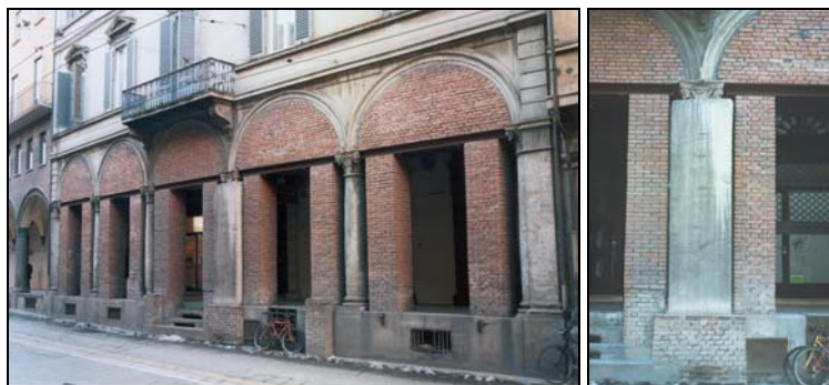
Figura 2 - Tamponamenti in muratura e particolare della colonna incamicciata
