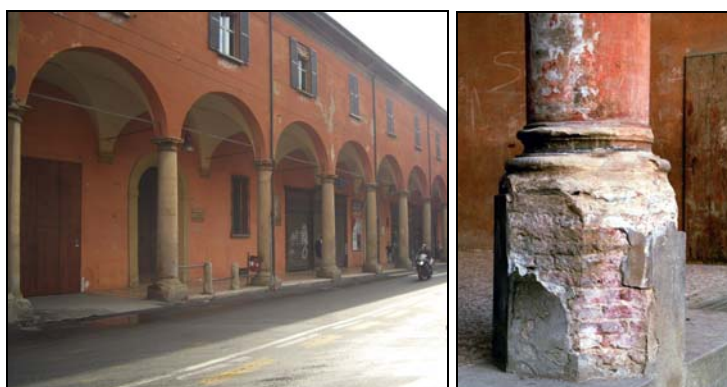
Figura 3 – Ex Convento di San Mattia: degrado della facciata e delle colonne
