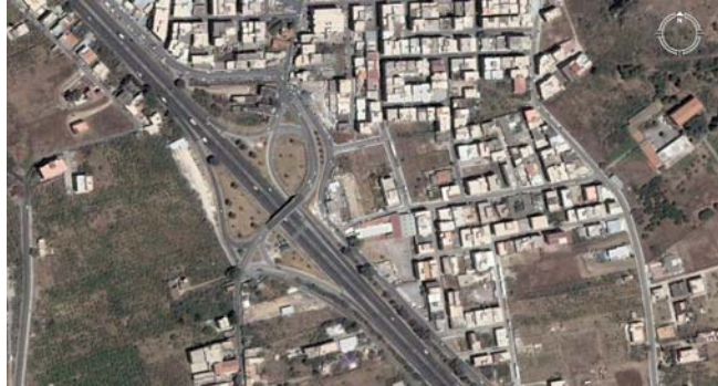
Figura 5 - Lo svincolo di Bagheria nella situazione attuale
